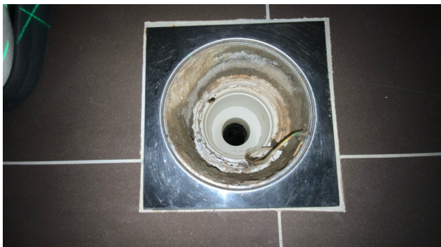
Kontroll av sluk.
