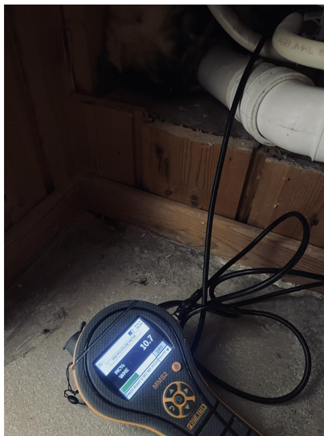
Fuktmåling inn mot bad.
