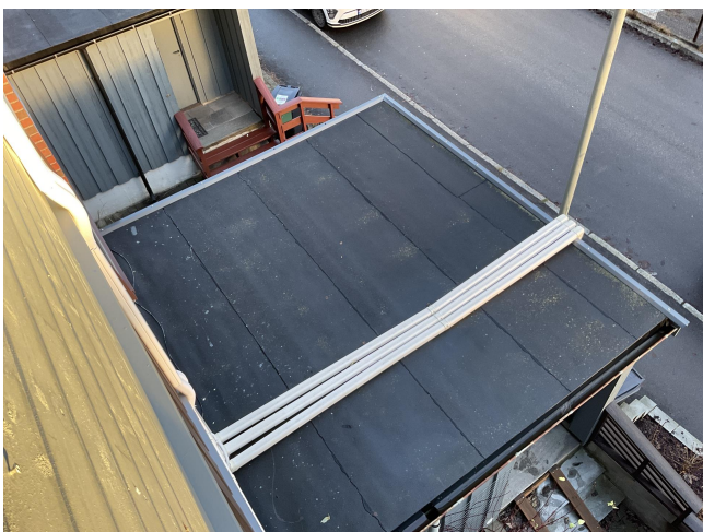
Papptekking over inngangsparti. Visuelt der det ut som at denne kan være fra 2012.
