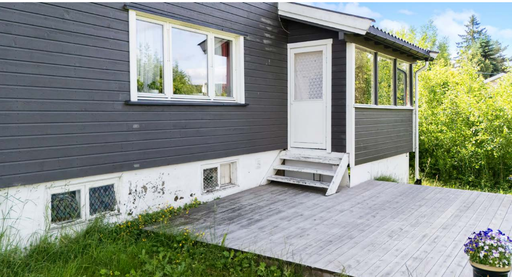
Terrasseplattung med enkel tilgang til hagearealer.
