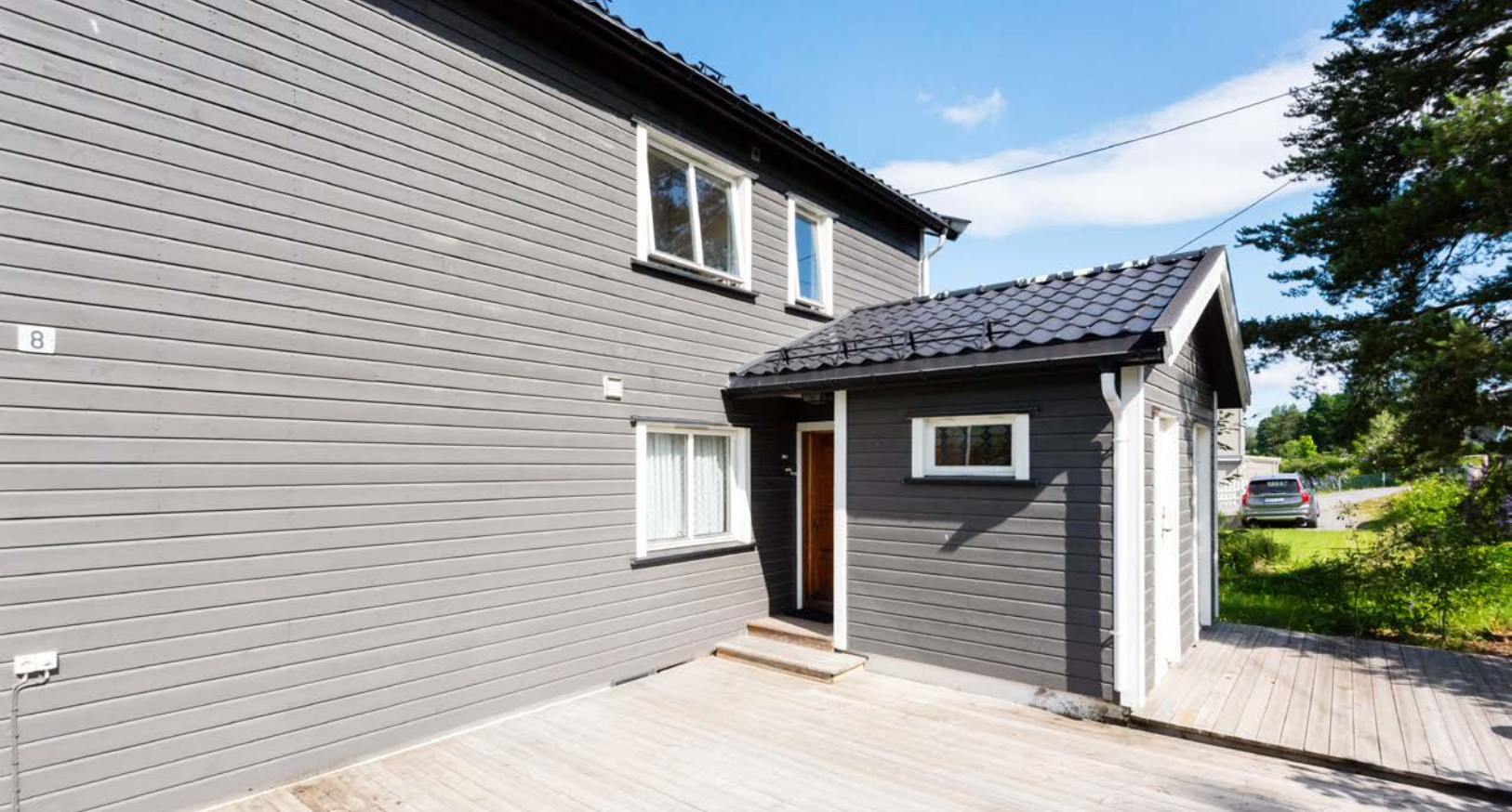
Terrasseplattung ved inngangspartiet.
