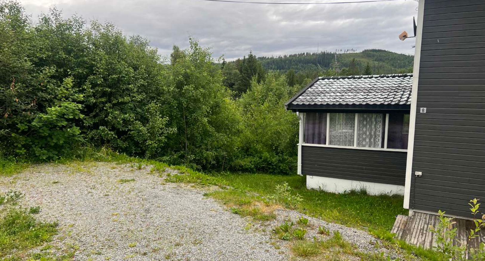
Gruset parkering ved boligen.
