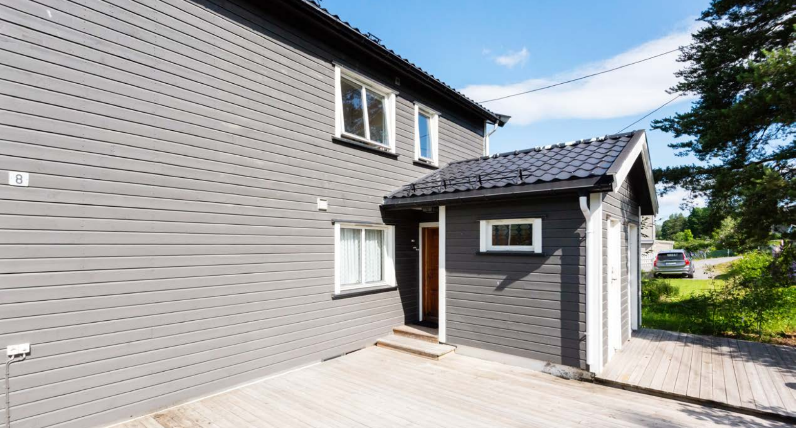
Terrasseplattung ved inngangspartiet.
