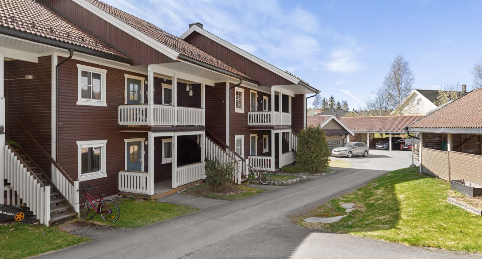
Fasade fremside. Sameiets felles tomt er opparbeidet med plenareal og asfalterte internveier.
