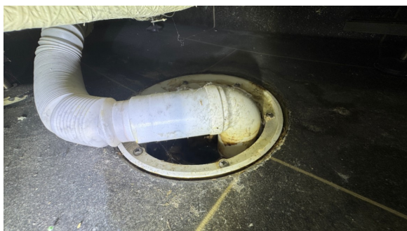
Kontroll av sluk.
