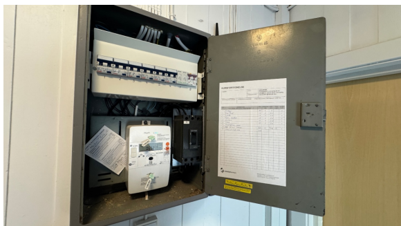
Kontroll av el-skap og kursfortegnelse.
