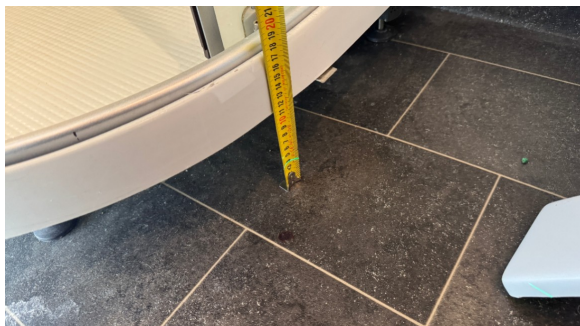
Kontroll av fallforhold.
