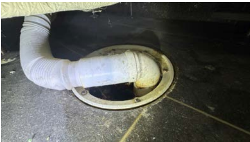
Kontroll av sluk.
