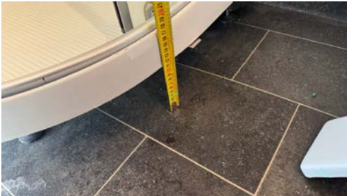
Kontroll av fallforhold.
