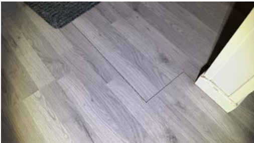
Det er registrert glipper i laminatskjøter.
