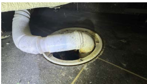
Kontroll av sluk.
