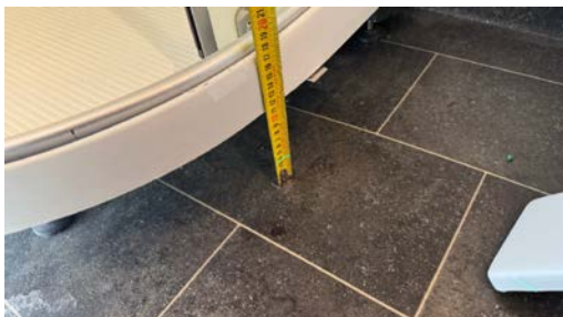
Kontroll av fallforhold.
