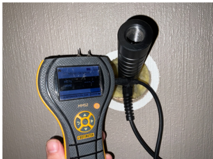
Fuktmåling i vegg ved hulltaking.
