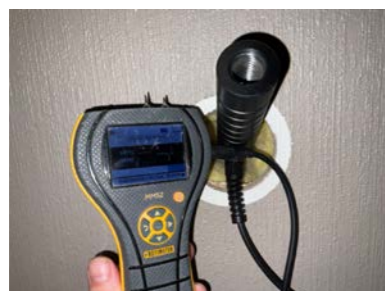
Fuktmåling i vegg ved hulltaking.
