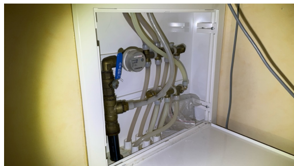
Innvendig hovedstoppekran og vannmåler er plassert i fordelerskap på badet.
