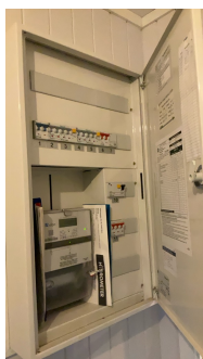
El-anlegg med automatsikringer. I hovedsak skjult ledningsnett. Sikringsskapet er plassert i entre.
