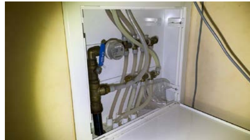
Innvendig hovedstoppekran og vannmåler er plassert i fordelerskap på badet.
