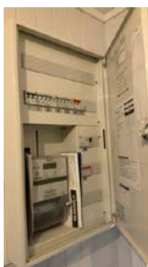
El-anlegg med automatsikringer. I hovedsak skjult ledningsnett. Sikringsskapet er plassert i entre.
