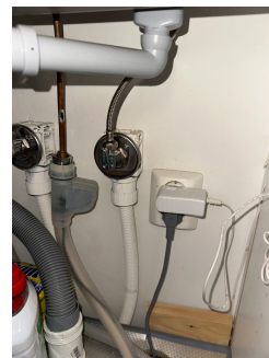
Rørapplegg i kjøkkenbenk med Waterguard
