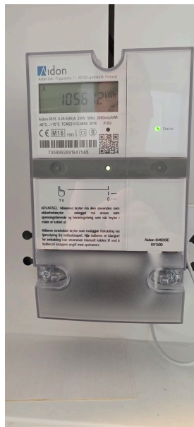
Bilde 2 Måler mangler plombering.
