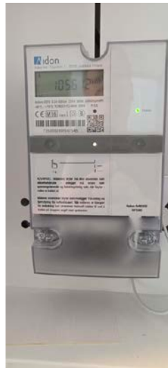
Bilde 2 Måler mangler plombering.
