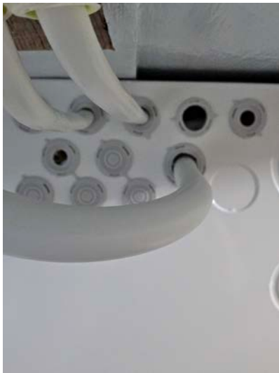
Bilde 1 Flere utette nipler i bunn skap.
