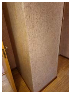
Pipe er kledd igjen i kjelleretasje.
