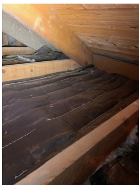
Lite lufting i loft i overgang vegg/tak
