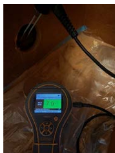
Fuktmåling i vegg mot våtsone.
