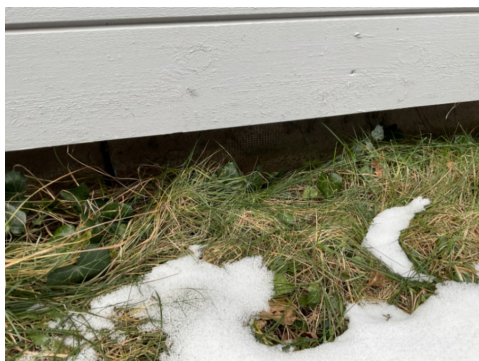
Isolerte elementer med fritt eksponert isopor
