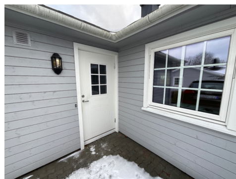
Inngangsdør og kjøkkenvindu
