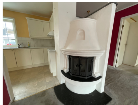
Peis med innsats, pipe og brannmur
