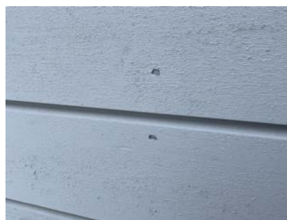
Spiker dypt i kledning
