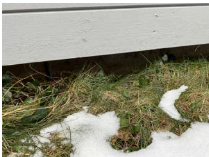
Isolerte elementer med fritt eksponert isopor
