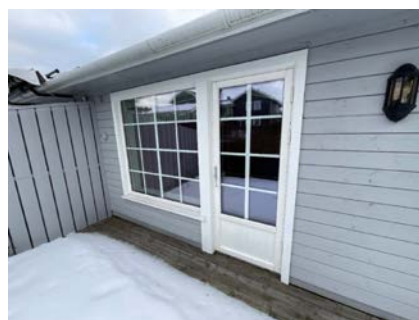
Terrassedør og stuevindu
