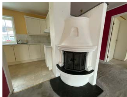
Peis med innsats, pipe og brannmur
