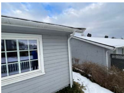
Ned løp og takrenner
