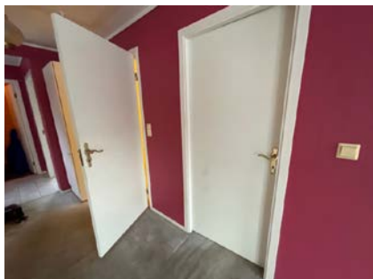
Bad og soveromsdør
