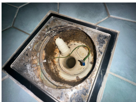
Sluk i plast, plassert i dusjnise
