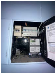
Sikringskap plassert i felles oppgang.
