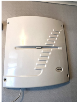
Kjøleromsaggregat i vegg- vaskerom.
