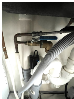
Noe irring på kobber. Teknisk rom.
