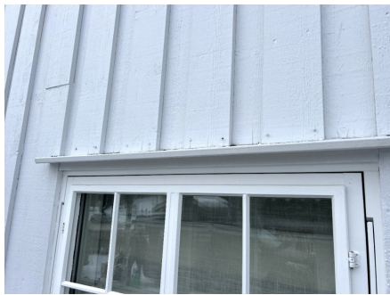
Kledning ned mot vannbrett.
