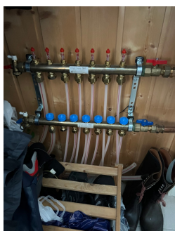
IVT Anlegg for vannbåren varme.
