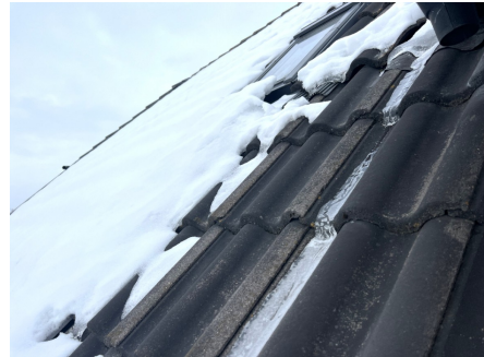
Tak fra balkong. Groing
