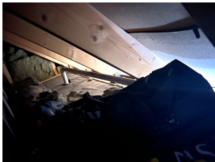
Takkonstruksjon fra kott/loft.
