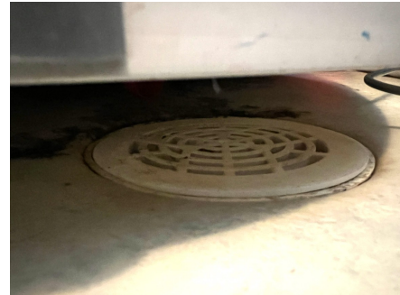
Sluk under varmtvannsbereder.
