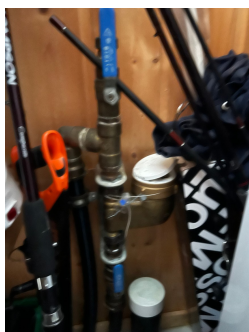
Vanninntak/stoppekran. Teknisk rom.
