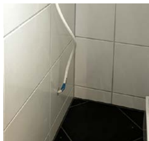
Gjennomføring med el-bakell- vegg bak dusjkabinett.
