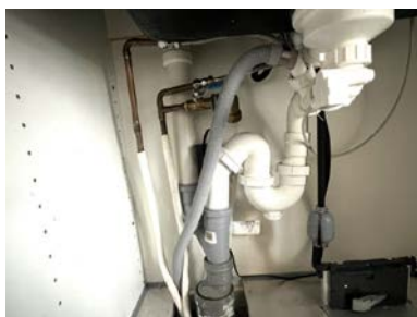
Vanninntak/stoppekran. Teknisk rom.
