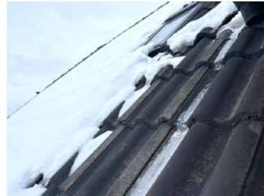
Tak fra balkong. Groing
