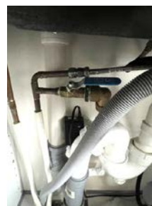
Noe irring på kobber. Teknisk rom.
