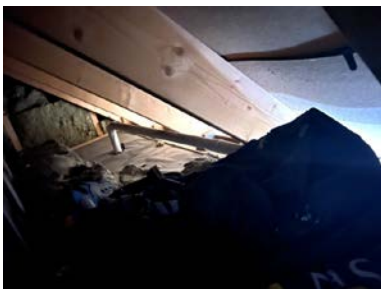
Takkonstruksjon fra kott/loft.
