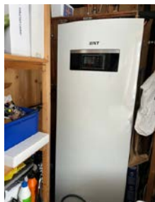
IVT Anlegg for vannbåren varme.
