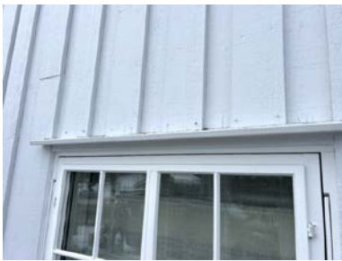
Kledning ned mot vannbrett.
