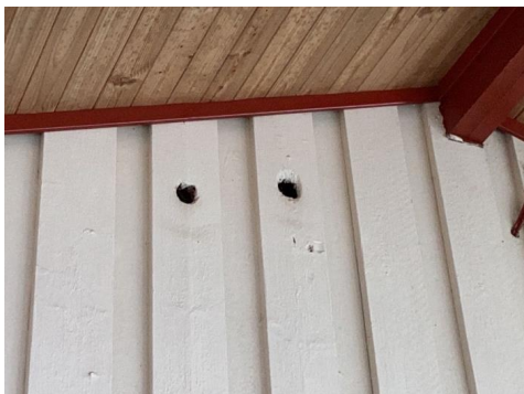
Eksempel på skade etter hakkespett.
