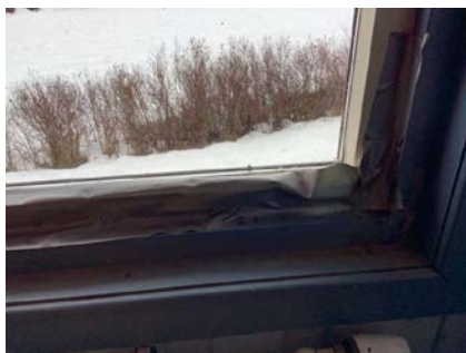
Et vindu er tapet igjen på innsiden.
