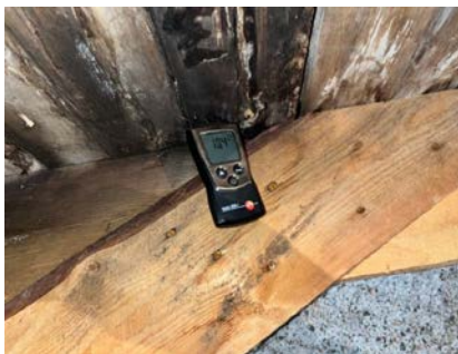
Det ble ikke målt forhøyet fuktinnhold på loft.
