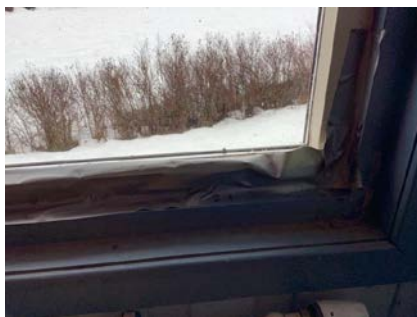
Et vindu er tapet igjen på innsiden.
