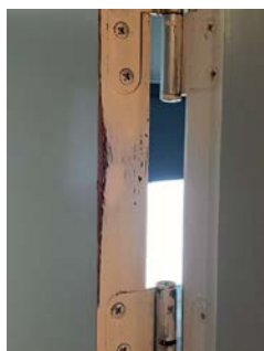
Skyvedørsblad med slitasje og manglende styrekloss i gulv.
