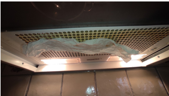
Test av avtrekket
