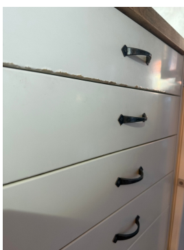
Bildet viser svellesskader på fronter.
