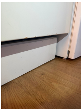
Bildet viser svellesskader på fronter.
