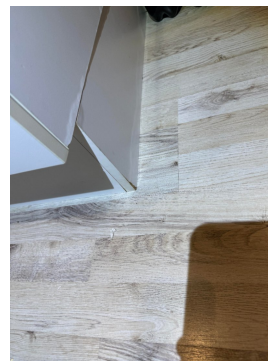
Bildet viser svelling på kjøkkenskrog.
