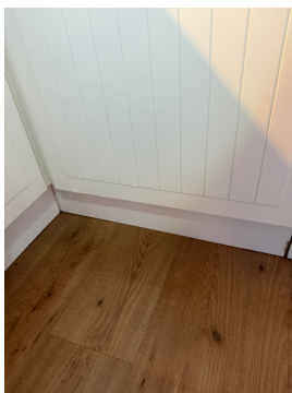
Bildet viser svellesskader på fronter.
