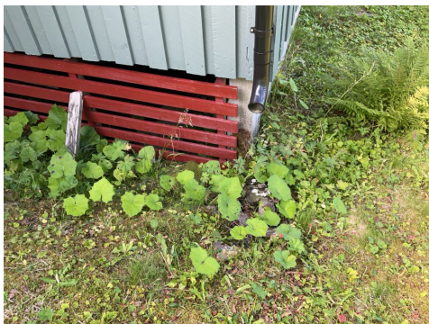
Taknedløp er ført ned mot terreng.
