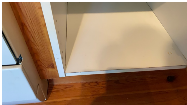
Fuktskader/utsvelling på skrog
