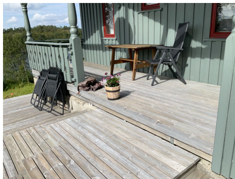
Over 10 cm åpning mellom rekkverk og gulv
