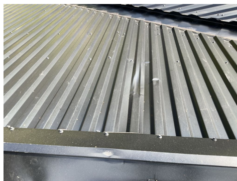
Bulker på takplater
