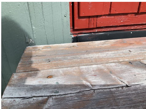
Beslag under dør er for kort
