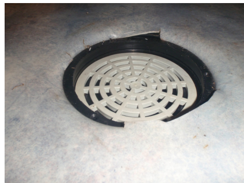
Belegg er ikke klemt i sluk
