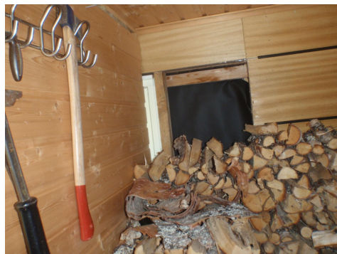
Manglende ferdigstillelse av overflater.
