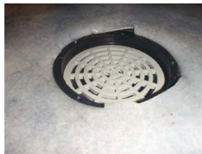
Belegg er ikke klemt i sluk
