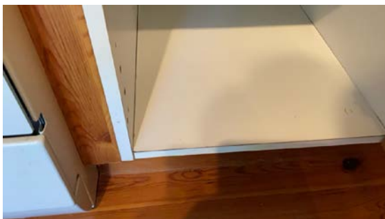
Fuktskader/utsvelling på skrog
