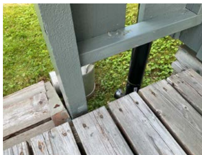
Over 10 cm åpning mellom rekkverk og gulv
