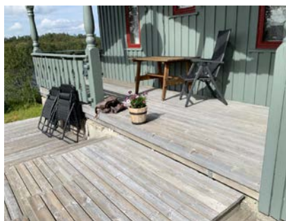
Over 10 cm åpning mellom rekkverk og gulv
