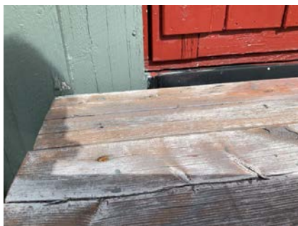
Beslag under dør er for kort
