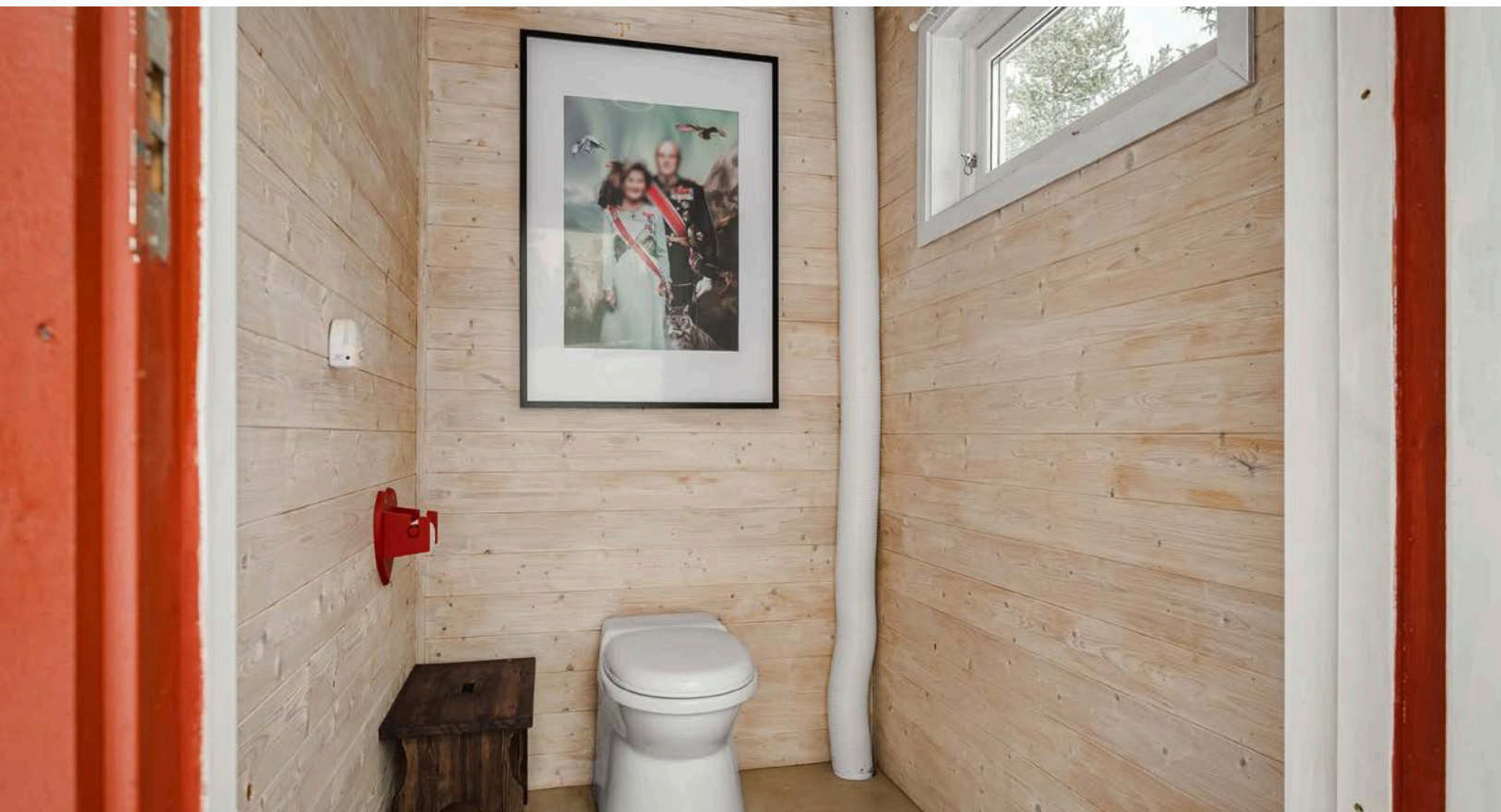
Toalettrommet har gulvflater med malte plater og panel i tak og vegger. Biодо.
