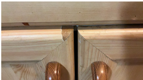
Overflateskade på skapdør
