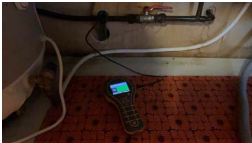
Ingen fuktutslag registret ved fuktmåling i vegg
