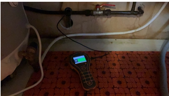
Ingen fuktutslag registret ved fuktmåling i vegg 29.10.2025
