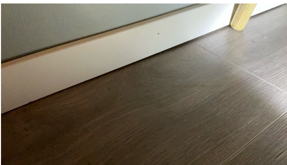
Åpning under gulvlist
