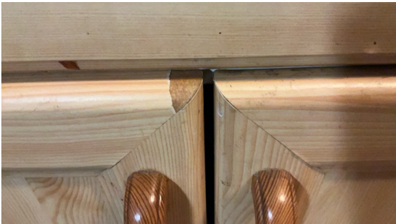
Overflateskade på skapdør
