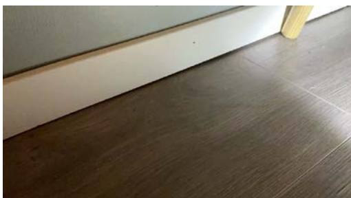
Åpning under gulvlist
