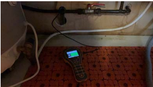
Ingen fuktutslag registret ved fuktmåling i vegg 29.10.2025
