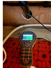
Ingen fuktutslag registret ved fuktmåling i vegg 13.03.2026
