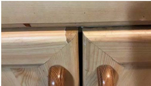
Overflateskade på skapdør
