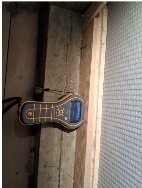
Bilde fra fuktmåling i vegg tilstøtende våtsone.
