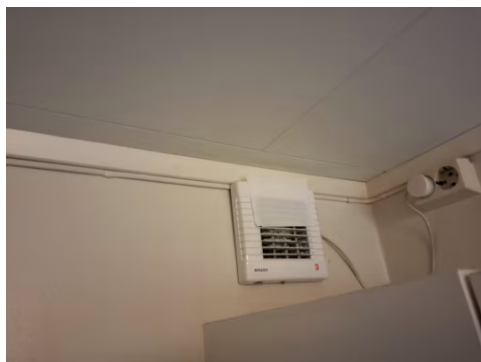
Avtrekkseffekt er testet med papir.
