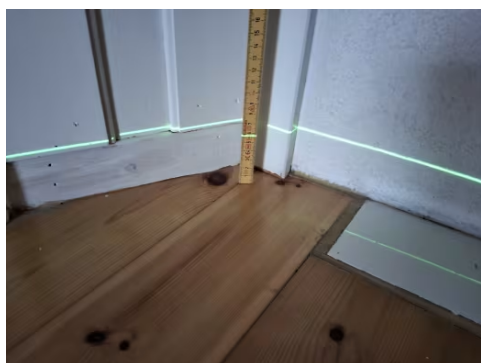
Etasjeskiller er kontrollert med nivelleringslaser.
