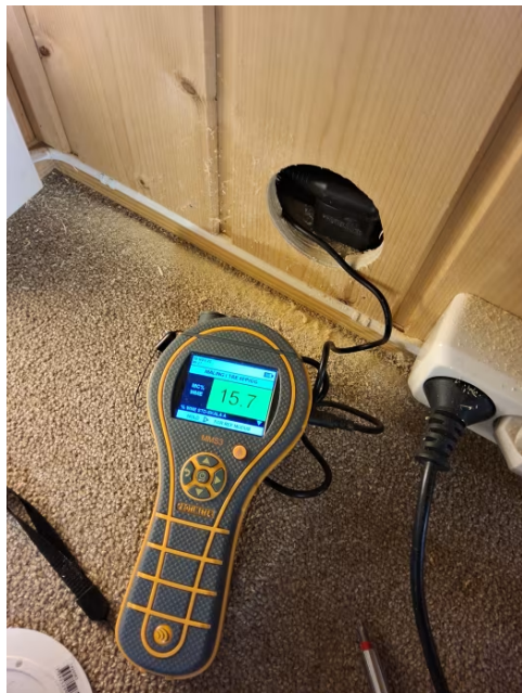
Bilde fra fuktmåling i utlektet veggkonstruksjon.
