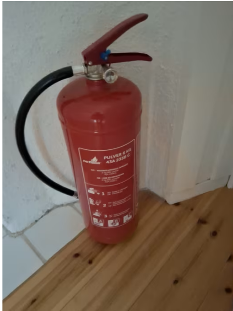
Boligen har brannslukningsapparat fra 2022.
