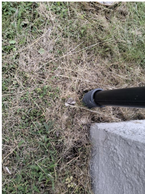
Taknedløp er avsluttet i drensør.
