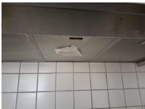
Avtrekkseffekt er testet med papir.
