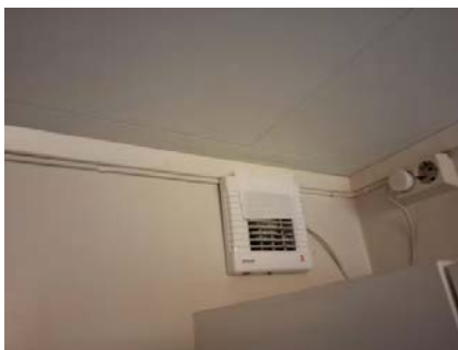
Avtrekkseffekt er testet med papir.
