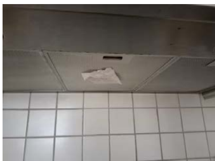
Avtrekkseffekt er testet med papir.
