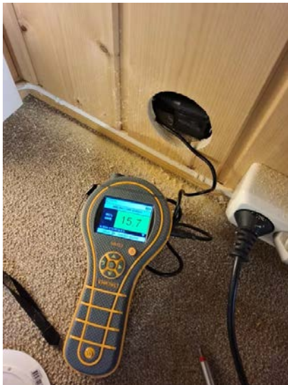
Bilde fra fuktmåling i utlektet veggkonstruksjon.
