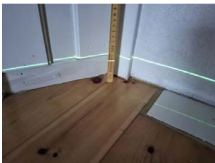
Etasjeskiller er kontrollert med nivelleringslaser.
