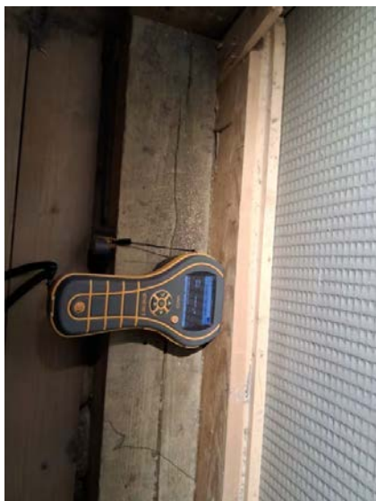
Bilde fra fuktmåling i vegg tilstøtende våtsone.
