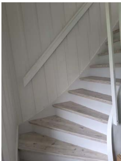
Trapp mellom 1. Etasje og loftsetasje.
