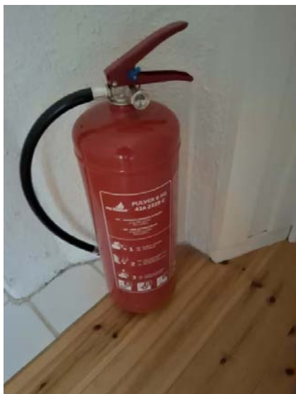
Boligen har brannslukningsapparat fra 2022.
