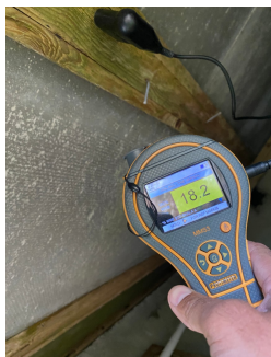
Fuktmåling i eksponert treverk på bjelkelag.
