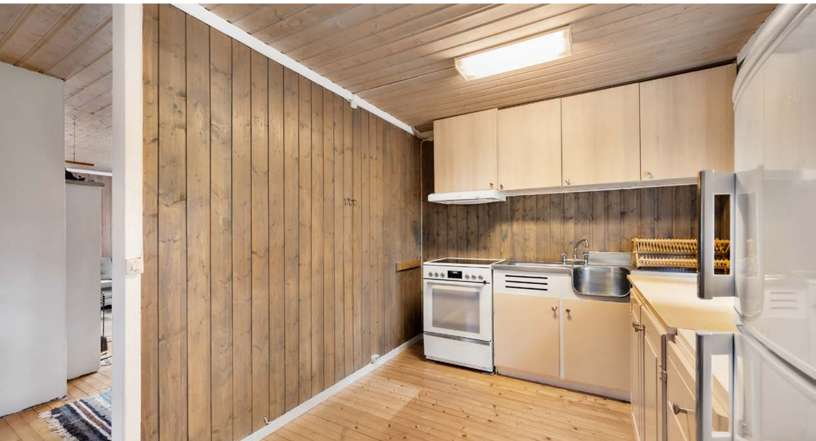
Innredningen består av ulike modeller, med lyse fronter i glatt og profilert utførelse og laminatbenkeplate, samt benkebeslag. Det er ikke innlagt vann.
