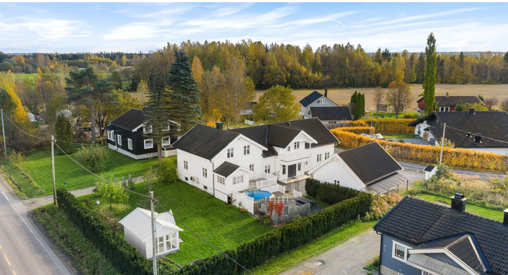
Boligen ble tilbygget i 2006-2007 med et større tilbygg med bla. godkjent utleiedel.
