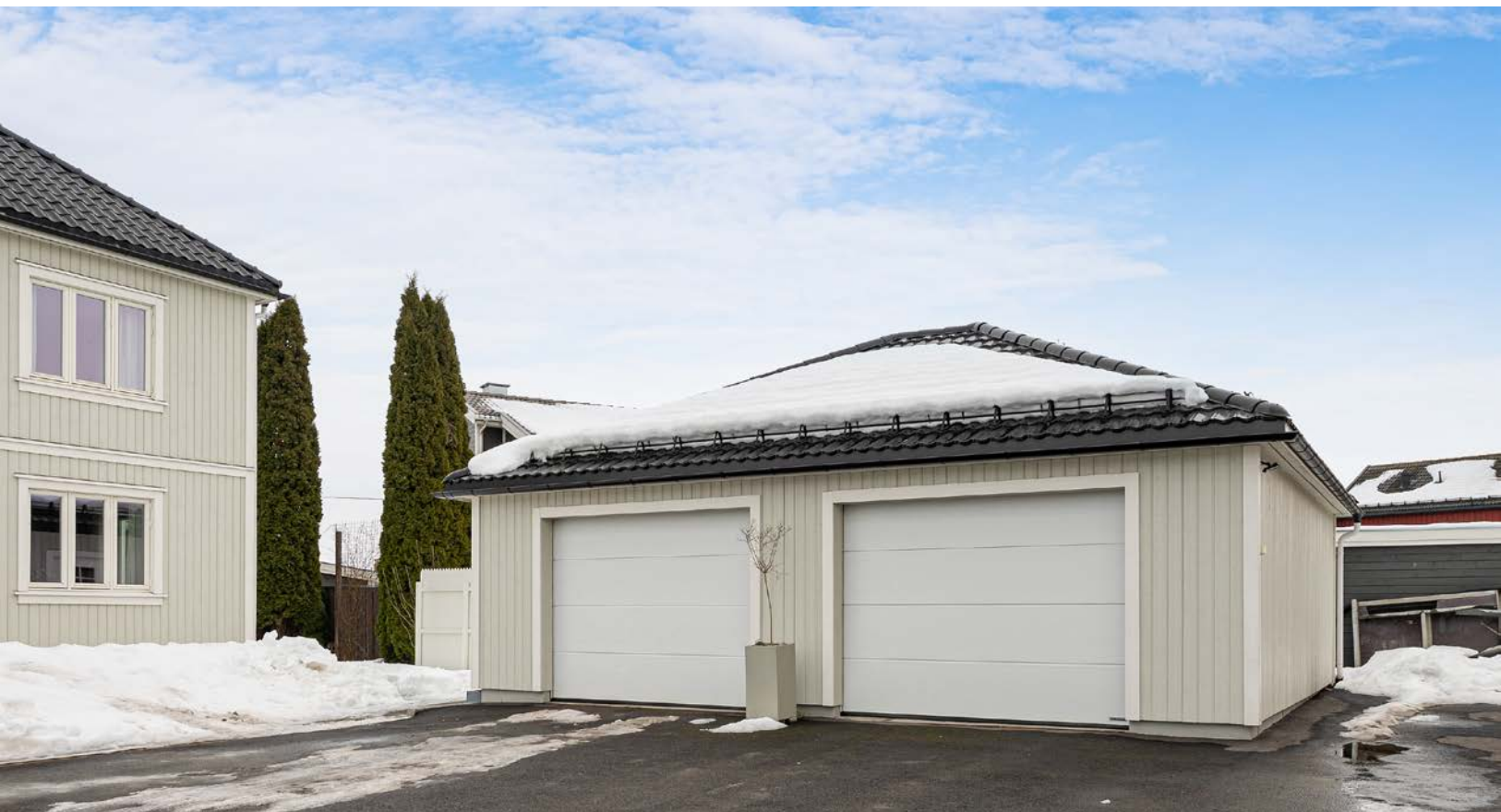
Stor dobbelgarasje på eiendommen.
