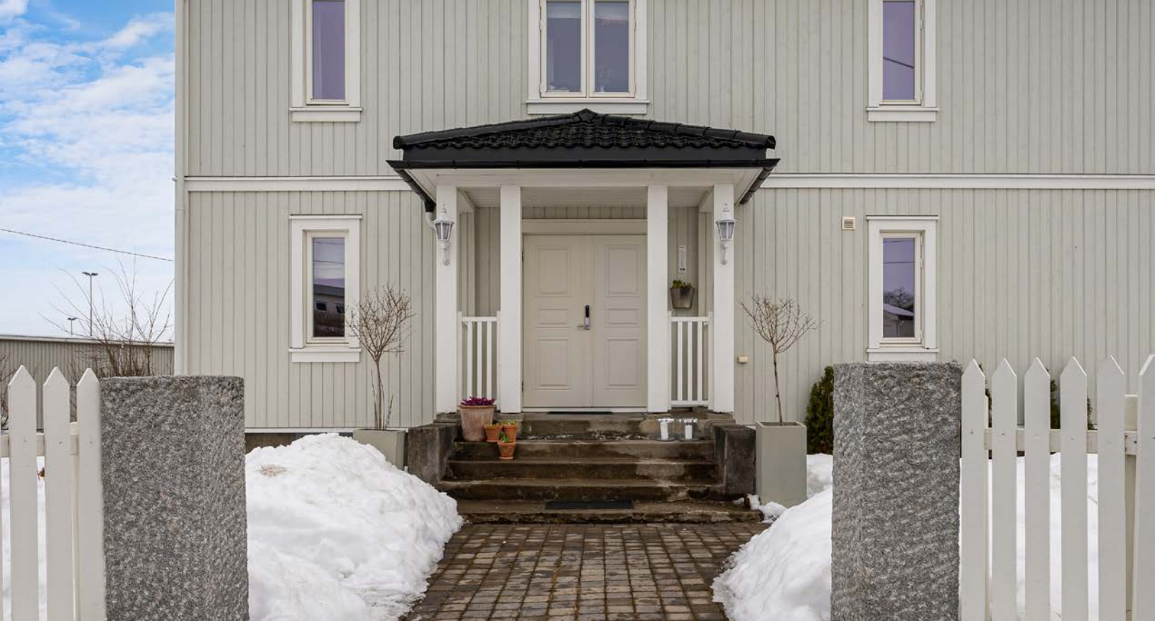
Et rent og pent uttrykk med belegningsstein foran inngangen.
