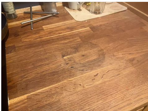
Merker på benkeplater.
