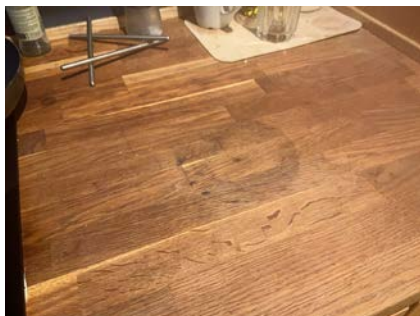
Merker på benkeplater.
