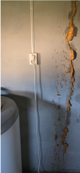
Bilde 1 Nyere installasjon bereder. Stikk burde byttes til rundstift. Det er et krav hvis installasjon er utført etter 2010
