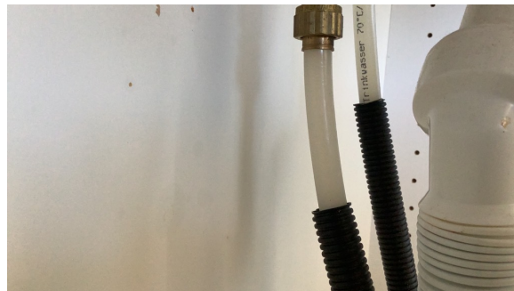
Det mangler tettemuffer i enden av varerør på kjøkken.
