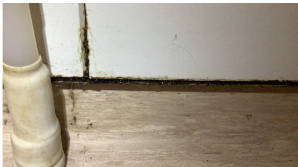
Fuktskadet baderomsplate.
