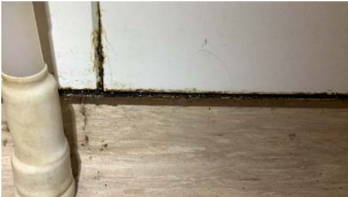
Fuktskadet baderomsplate.
